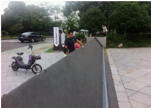
图 3 气盾坝防洪墙
