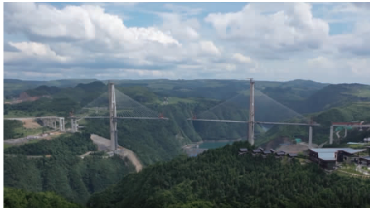
图4 桥址区地形地貌 2
