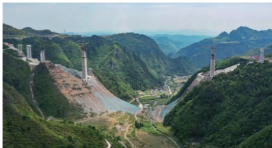
图3 桥址区地形地貌 1
