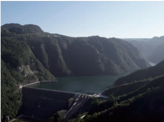
图 6 窄冲水库大坝
