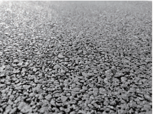
图 5 实施后罩面表面构造均匀、丰富
