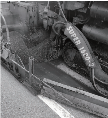
图 3 同步摊铺喷洒一体化技术示意
