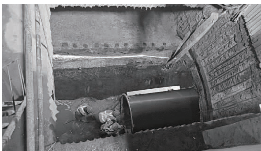
图 13 上游井位中导管运输实例
