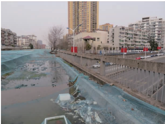
图 3 东一环铁路桥桥面系外观病害现场检查照片
