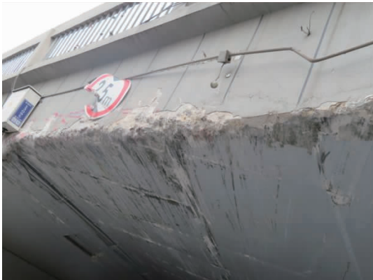
图 2 东一环铁路桥上部结构外观病害现场检查照片
