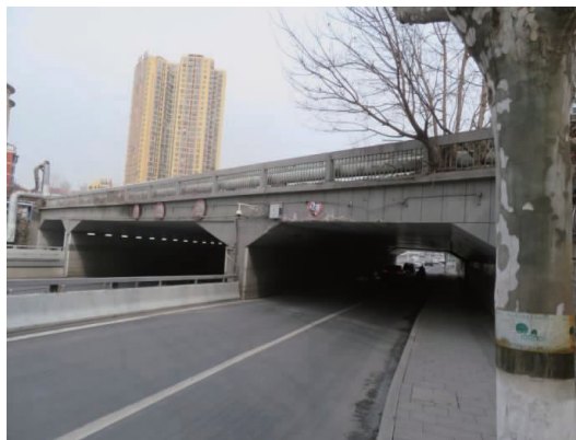
图1 东一环铁路桥现场实景图
