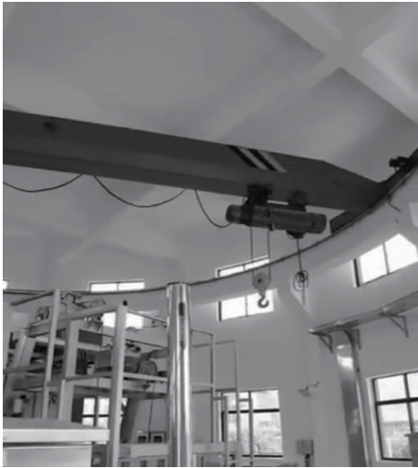
图 5 圆形混凝土吊车梁
