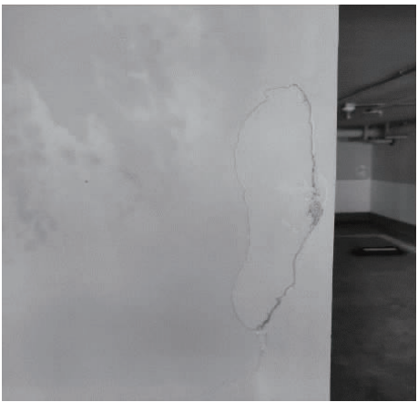
图 4 墙柱面爆灰
