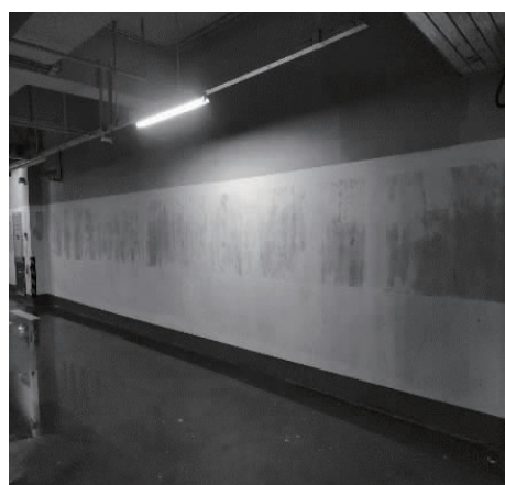
图6 墙面涂料受结露影响
