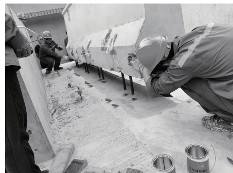
图5 预制护栏安装
