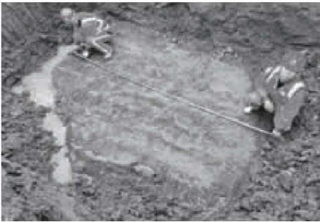
图 1 RJP 开挖桩头直径
