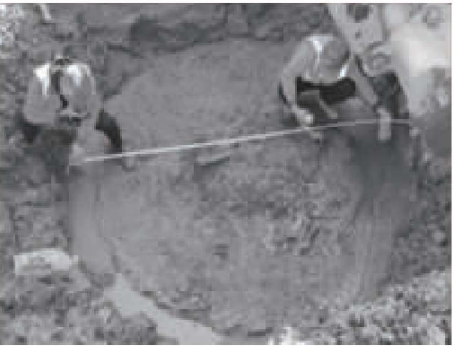
图 3 SJT 开挖桩头直径
