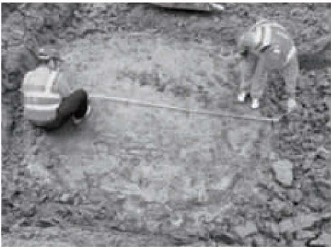
图 5 MJS 开挖桩头直径
