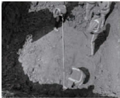
图8 D-RJP开挖桩头直径
