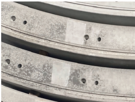
图 1 水溶液养护后的管片表面
