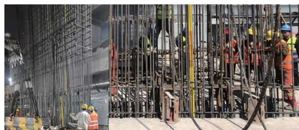
图 13 钢筋笼对接使用千斤顶进行辅助
