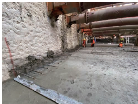
图 15 基坑开挖面墙体情况
