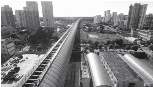
图 1 津兴铁路全封闭声屏障概貌
