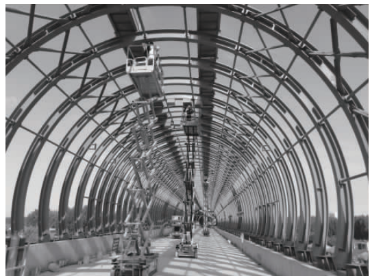
图4 拱架间距测量
