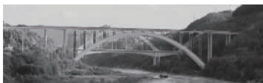
(a) 景海高速澜沧江特大桥
