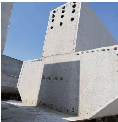
图 17 盖梁湿接缝处断面
