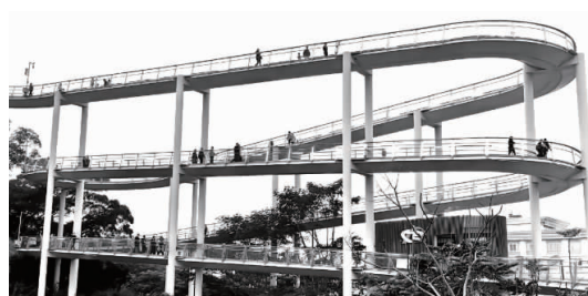
图1 观音寺螺旋坡道实景图
