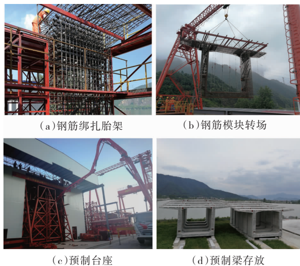
图10 节段预制过程
