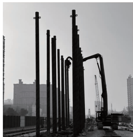
图6 #1~#20 钢管桩打设(未使用导向架)
