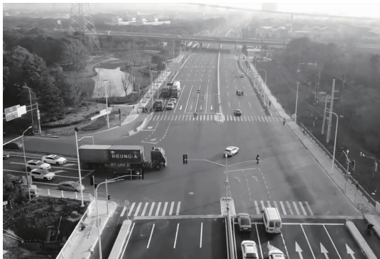
图10 沪南公路-S2沪芦高速收费口交叉口改造后现场图
