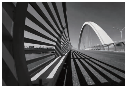
图 12 桥梁局部大样实景图(二)
