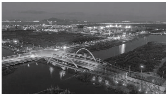
图 10 桥梁夜景实景图
