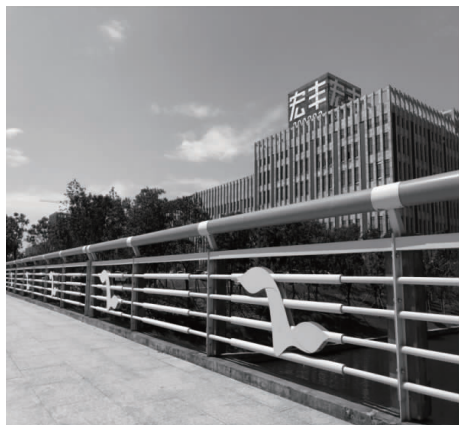
图 13 栏杆大样实景图(一)
