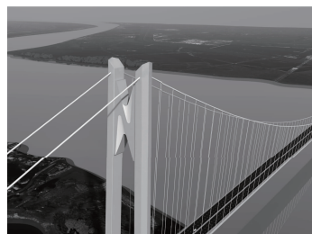
(a)仙新路长江大桥 N 字形装饰全景图
