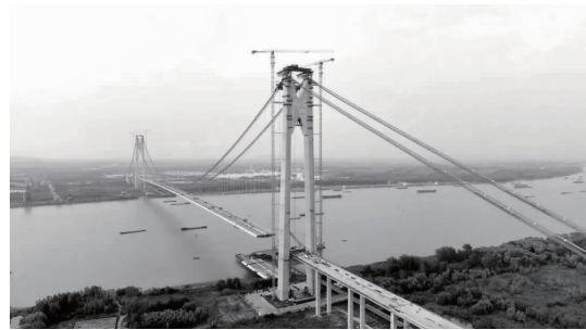
图 13 仙新路大桥“N”字形钢结构架设完成图
