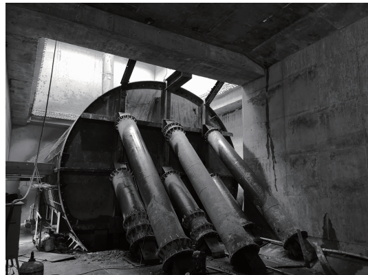
图7 反力架支撑安装图
