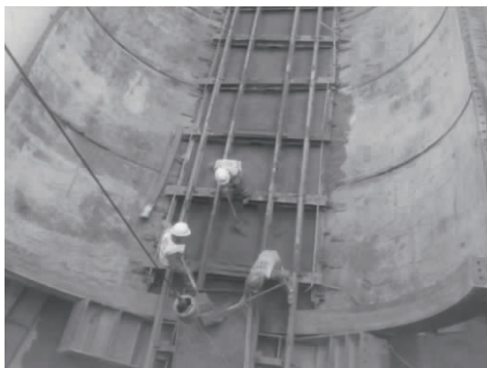
图4 钢套筒底部填砂图
