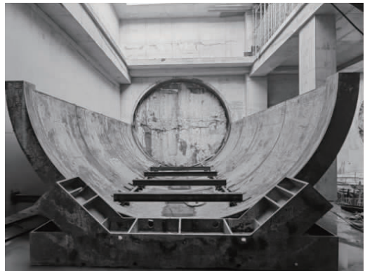
图2 钢套筒及反力架下半部安装图
