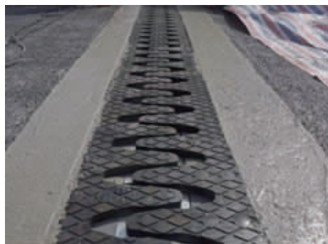
图 7 混凝土施工完成
