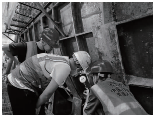
图 8 钢套筒保压试验图
