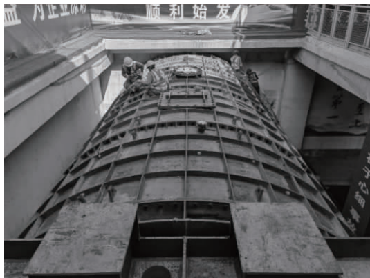
图6 钢套筒内盾构机主机拼装图
