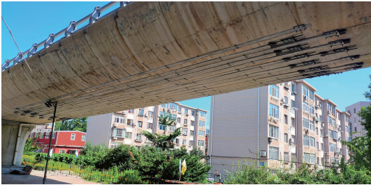
图 10 加固后现场照片
