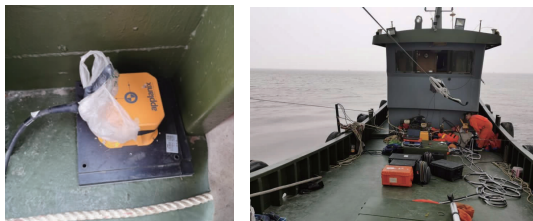
图7 惯性导航系统安装
