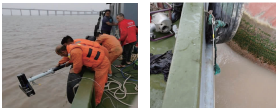
图6 多波束安装及加固
