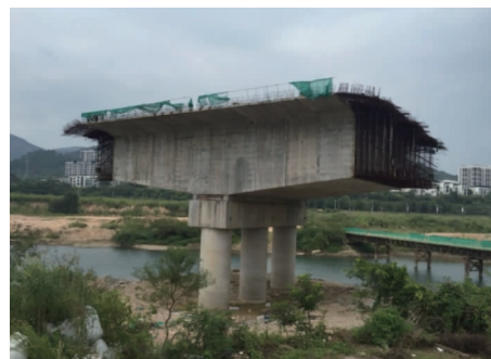
图 1 已施工桥梁现状图
