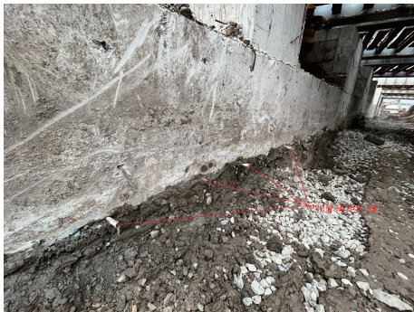
图9 浇筑完成后 PVC 管
