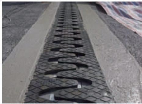
图 7 混凝土施工完成
