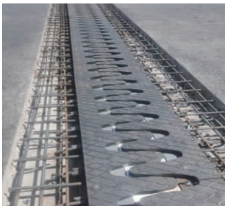
图 4 伸缩缝安装
