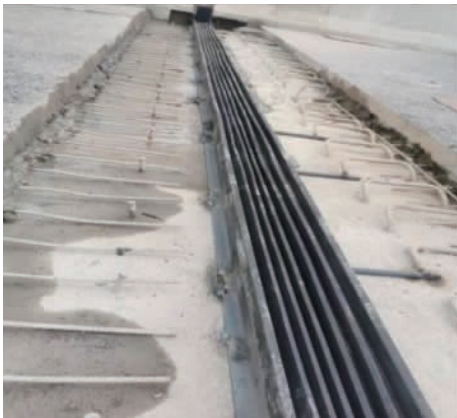
图 3 止水带安装图
