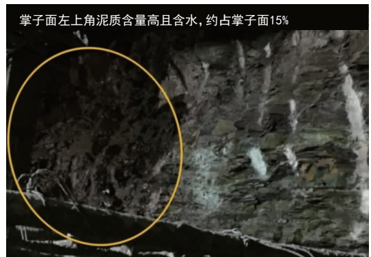
图7 掌子面拱顶及左拱肩局部为软弱围岩
