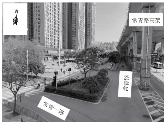
图1 常青路东侧现状高架周边环境影像
