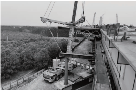
图12 挑臂单元吊装现场照片
