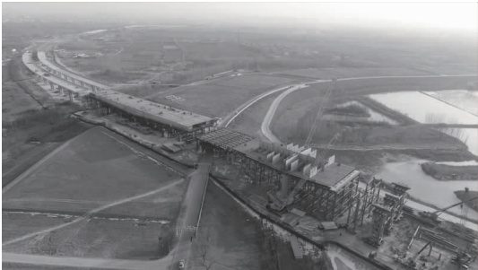
图 11 中间箱体胎架上散拼现场照片
