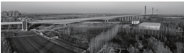
图 1 济南凤凰黄河大桥及其引桥
