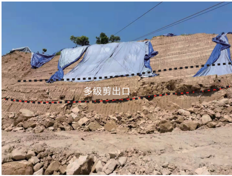
图2 昔格达地层滑移时的多级层间剪出口
