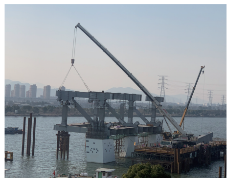
图8 MB20、MB19节段吊装施工图
