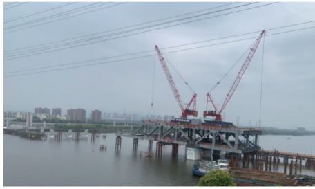
图9 架梁机吊装钢桁梁节段示意图
