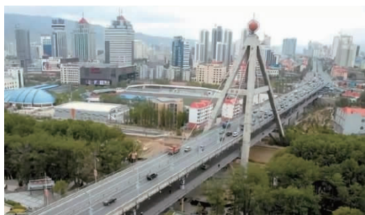
图2 昆仑桥老桥实景图
