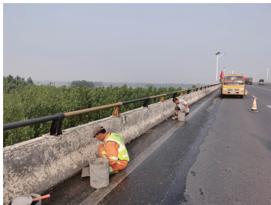
图 3 护栏修补施工现场
