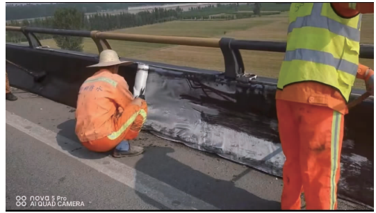
图 4 高分子防腐涂层施工现场
