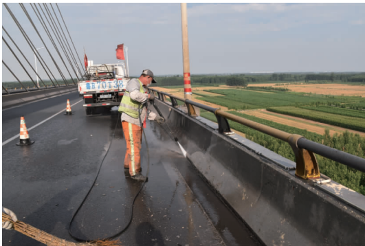
图 2 对大桥护栏进行高压水冲洗现场
