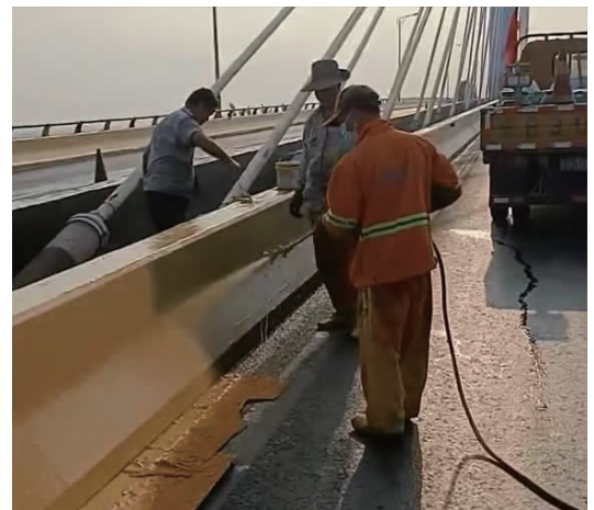
图 5 聚碳硅氧烷防腐涂层施工现场
