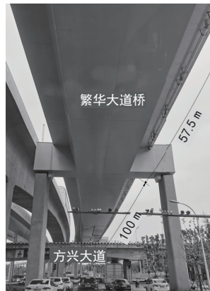
图 1 工程现场图(建成后)
