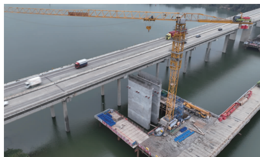
图 5 东江特大桥 4# 墩实景图 的可行性,可供类似工程参考。
