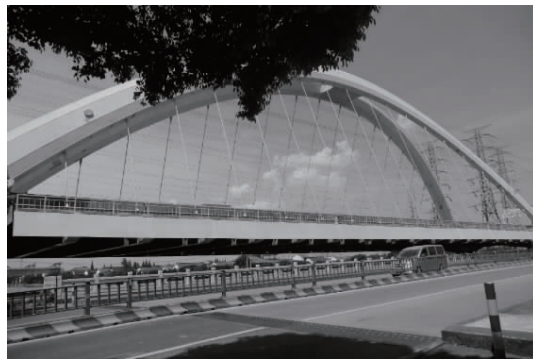
图 3 油墩港桥实拍图
