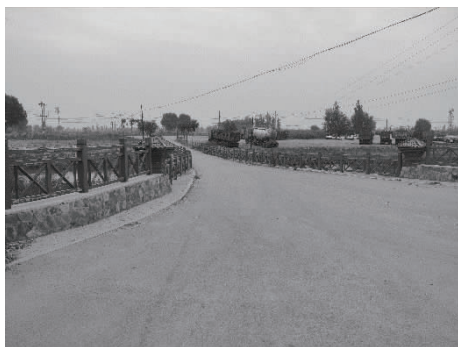
图6 现状桥梁交叉口
