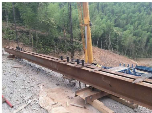
图 4 钢绞线与承台预埋精轧螺纹钢的连接图
