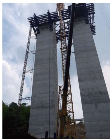
图 6 钢绞线反拉系统完工
