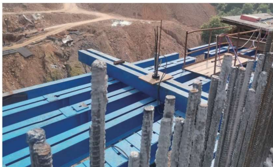
图7 单股张拉千斤顶安装
