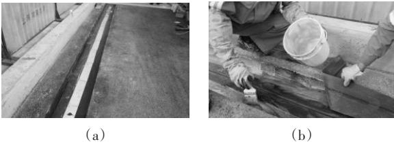
图 4 弹性混凝土拼缝防水处理
