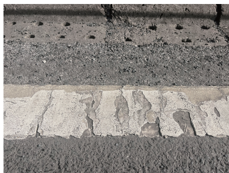
图 3 旧标线脱落
