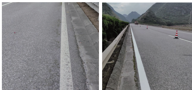
图 6 修复前、修复后标线外观
