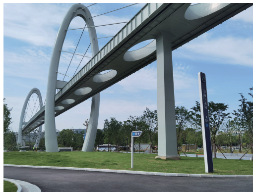
图1 光谷高新大道桥全貌
