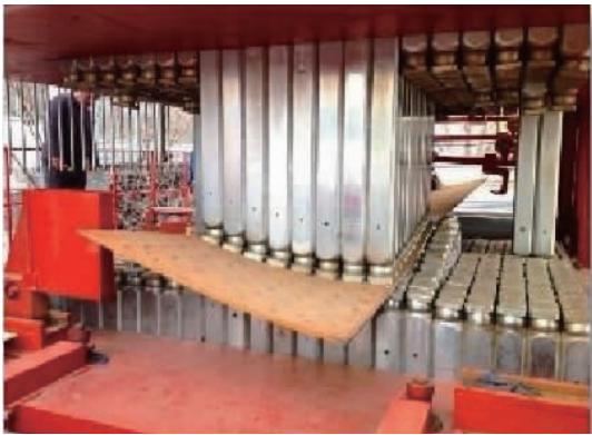
图 4 塔顶段壁板压型
