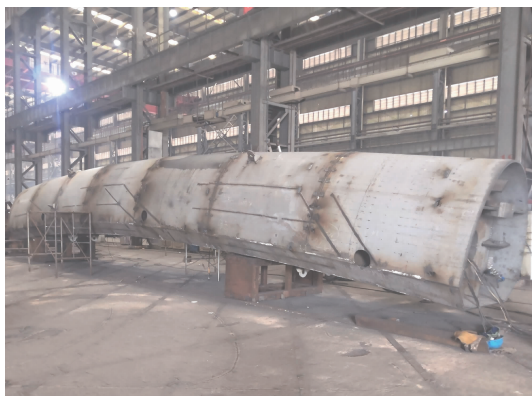
图7 钢塔节段出胎焊接
