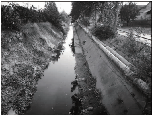
图 3 冯北路西侧现状排涝沟
