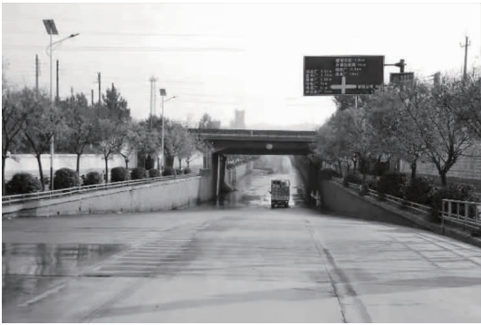
图 9 冯北路下穿胶济客专框架桥
