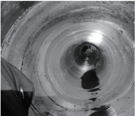
图 13 非开挖修复后污水管道图
