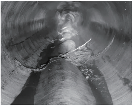
图 12 非开挖修复前污水管道图
