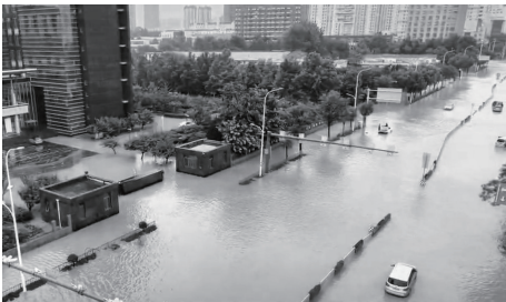
图3 鲁泰大道局部路口积水
