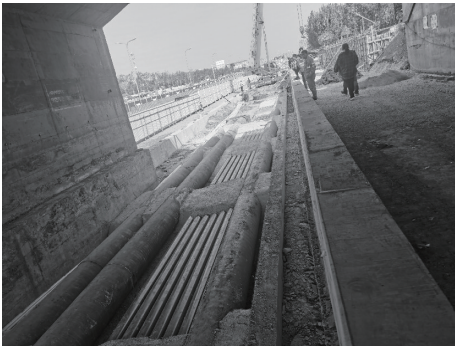
图2 原山大道下穿铁路排水管线
