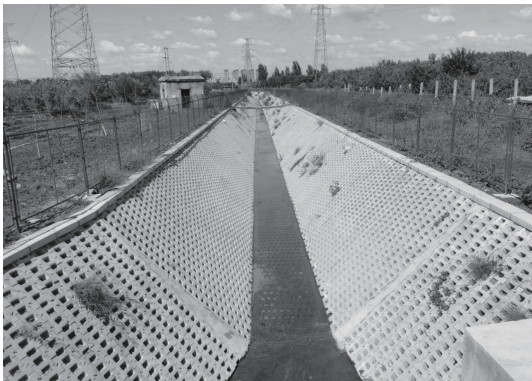
图7 梯形断面排涝沟
