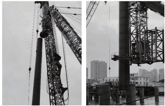
图6 打桩船立桩
