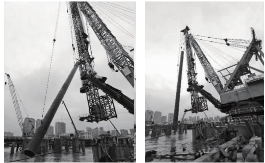
图6 打桩船立桩
