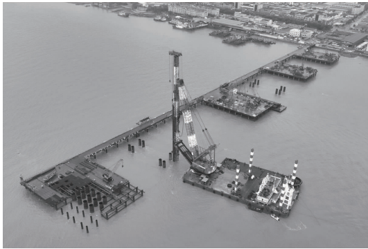
图9 钢护筒沉桩施工图
