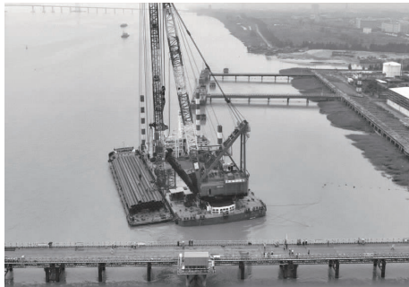
图4 运桩船靠泊打桩船
