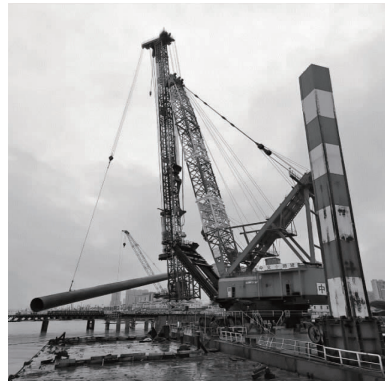
图5 打桩船起桩
