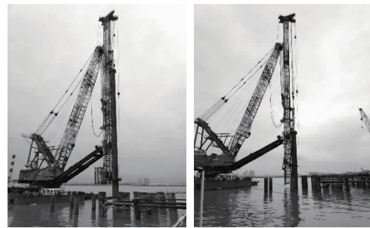
图8 钢护筒沉桩
