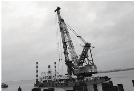
图3 打桩船抛锚定位
