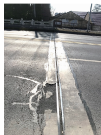
(a)改建前:路面有缝,易损、跳车
