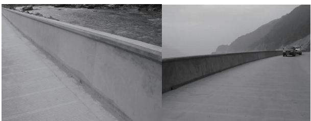
(b)阻爬坎+单坡面型混凝土护栏
