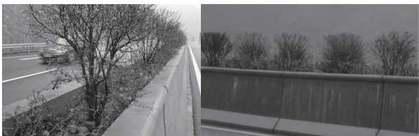
(a)加强型混凝土护栏
