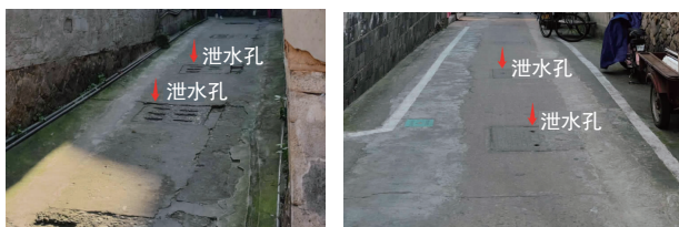
图4 现场排水实景(泄水孔)
