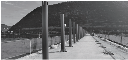
图 4 基础施工实景
