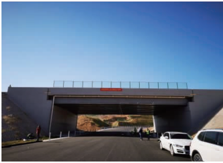
图1 钢-混组合工字简支梁桥实景照
