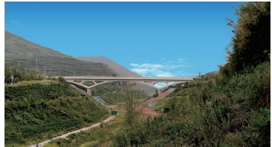
图9 成桥合拢现场照片
